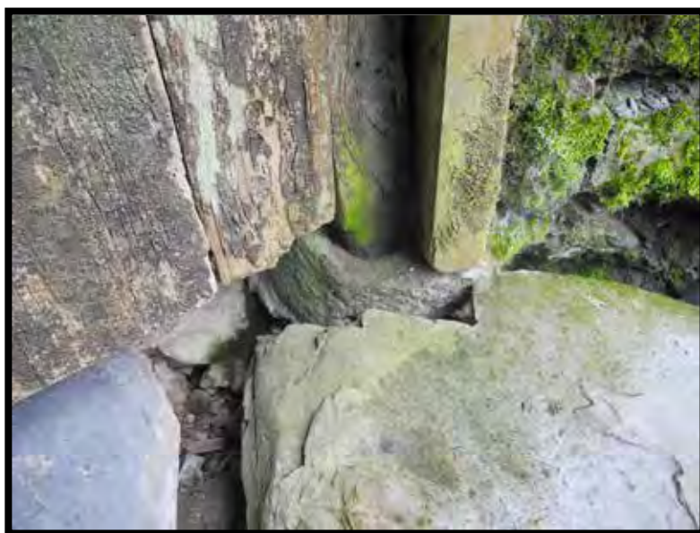
Plate 5: Harr Hung door & socket
